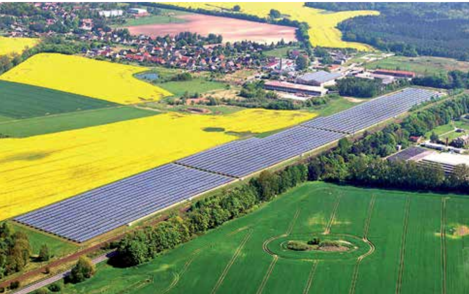
Solarpark der Krannich Solar GmbH
