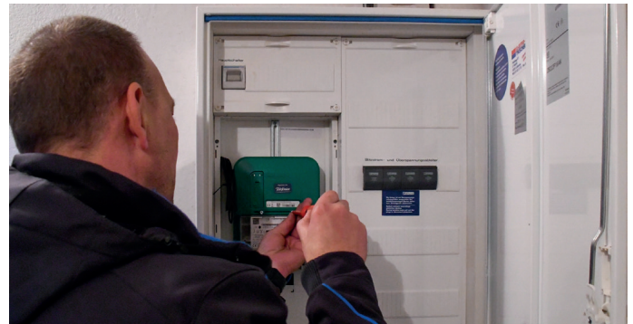
Installateur Tino Kircheis (DTW Networks) übernimmt pro Woche ungefähr 30 Zählerumbauten unter der Regie von Discovery.
